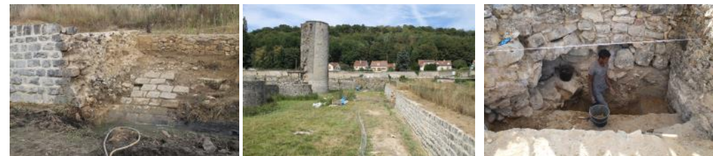
Travaux de maçonnerie (rebouchage de la contrescarpe) et sondages du château
